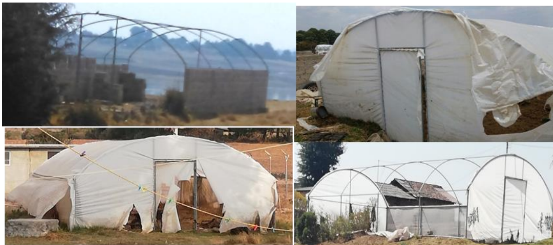
Figura 15. Daños del plástico de micro túneles.
