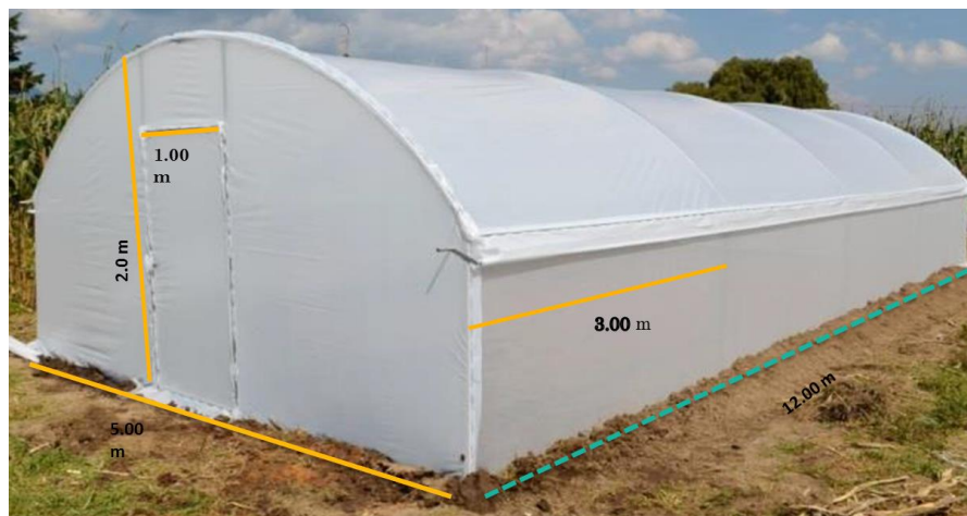
Figura 1. Diseño de micro túnel de 60m 2
