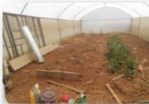
Falta de agua
